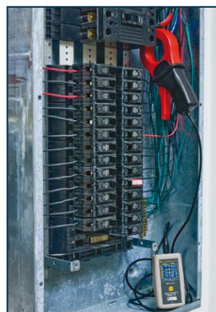
Registro de la corriente de un circuito de derivación con el L101
