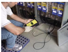
Identificación de cable con el receptor IC1G-RX
